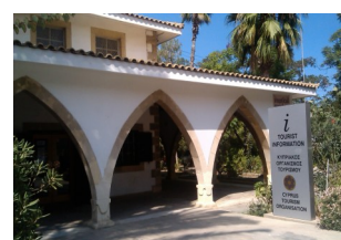
Здание информационного офиса (КОТ)
